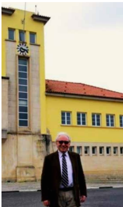
foto 3. RI5 - edifício do comando
